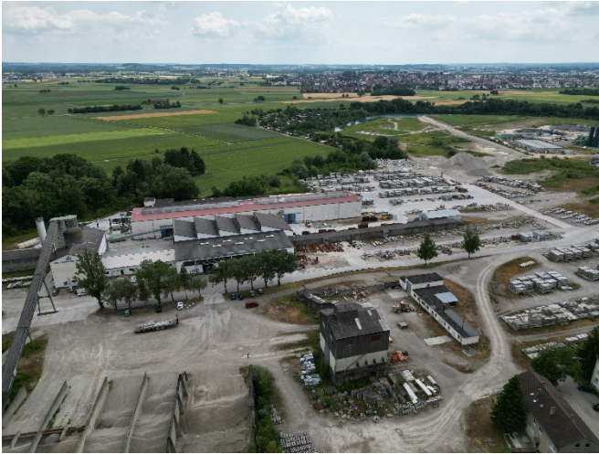
Standort Betonwerk Neu-Ulm
