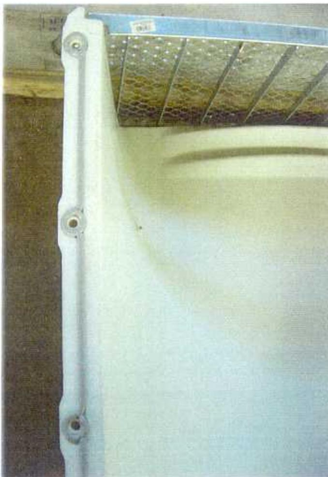
Bild1 Mit AC0 Profix gefüllte Kittrille des Lichtschachtflansches
