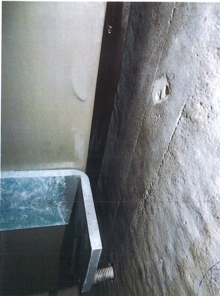
Bild 3: Absetzen des Lichtschachtes auf dem unteren Bolzenanker
