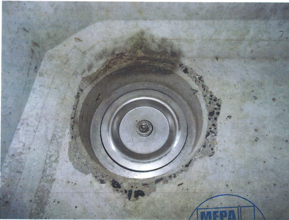
Bild 1: druckwasserdichter Verschluss der Ablauföffnung
