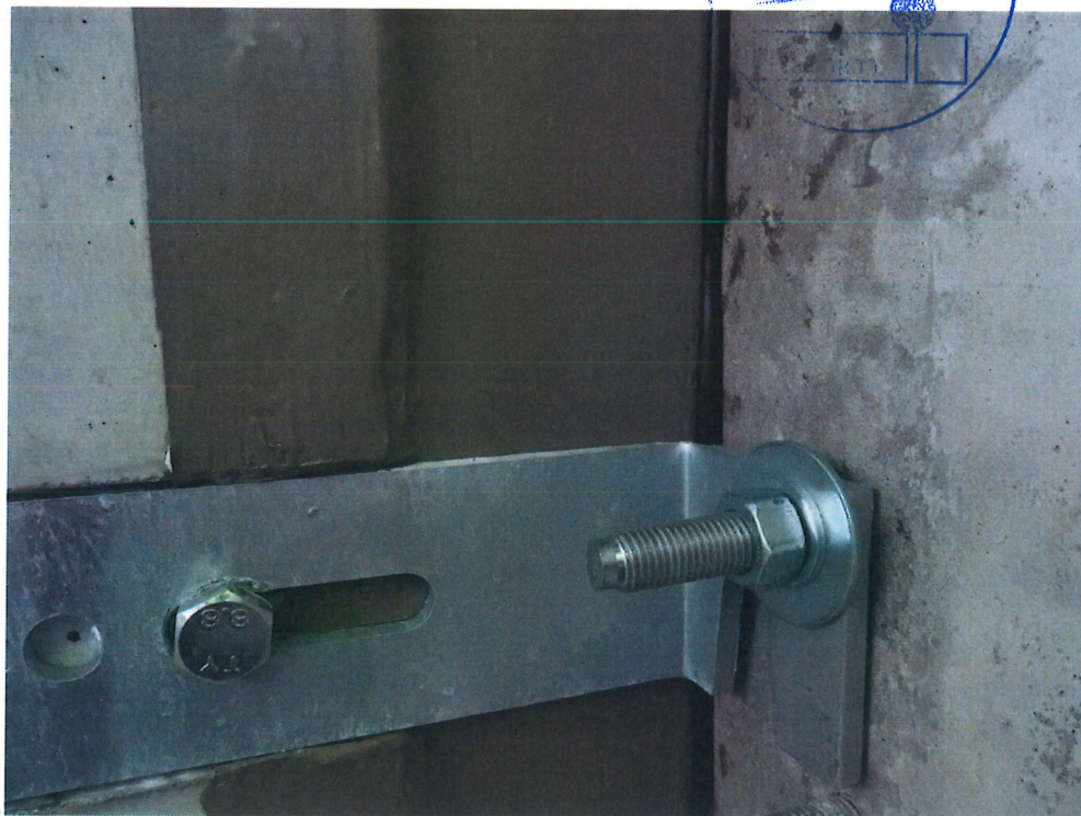
Bild 4: Verankerung des Lichtschachtes; hier am oberen Befestigungswinkel
