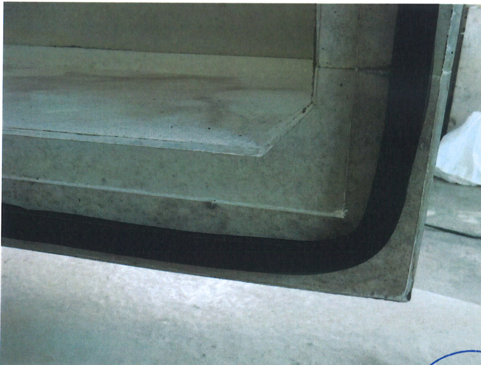
Bild 3: Verlegung von ACO Dichtfix im Eckbereich des Betonlichtschachtes
