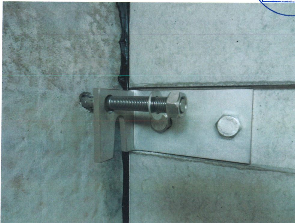
Bild 4: Setzen der oberen Bolzenanker
