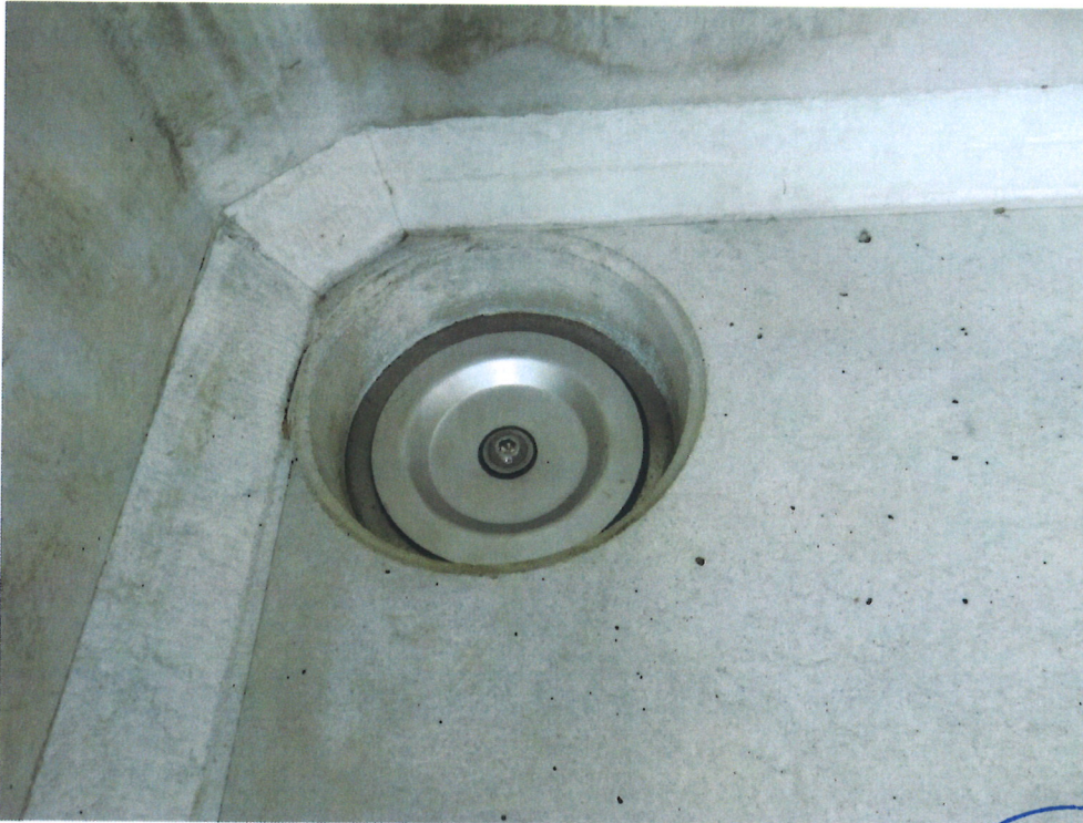
Bild 1: druckwasserdichter Verschluss der Ablauföffnung
