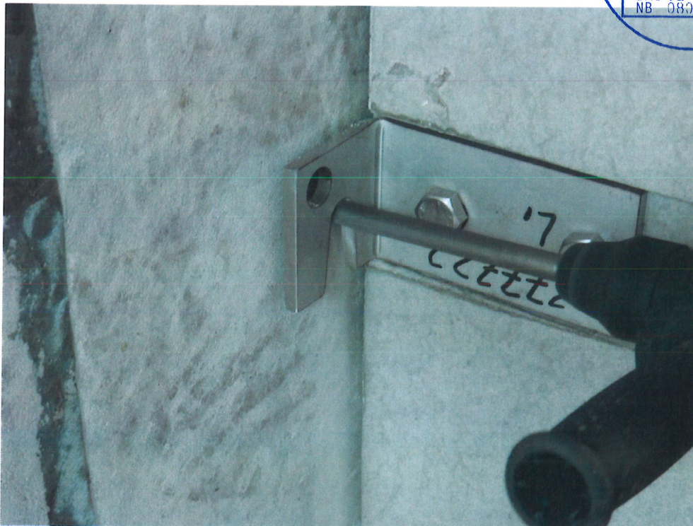
Bild 2: Bohren der unteren Löcher in die Stahlbetonwand
