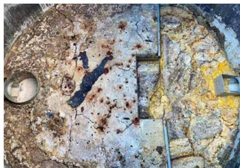
Zurückgehaltene Schmutzstoffe in einem Fettabscheider vor Einleitung in die Kanalisation
