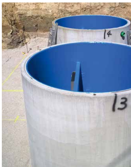
Einbau einer Behandlungsanlage mit RAL GZ 693 an einer Tankstelle © Foto: GET
