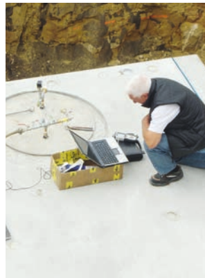
Druckluftprüfung auf Dichtigkeit
