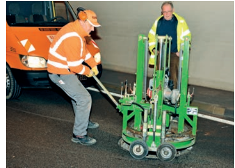
Ziehen des alten Rahmens der Schachtabdeckung
