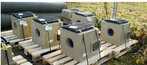
Tauchwandschächte bereit zum Einbau
