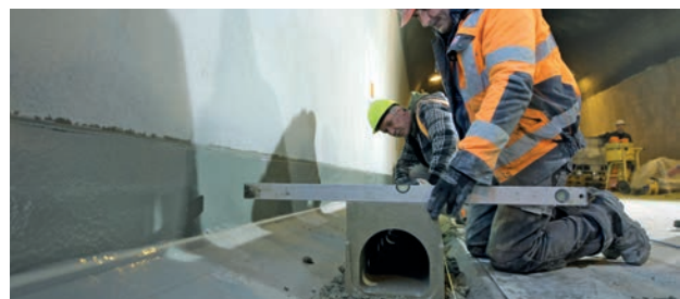
Ausrichten der Tunnelrinne, Foto: Michael Staudt
