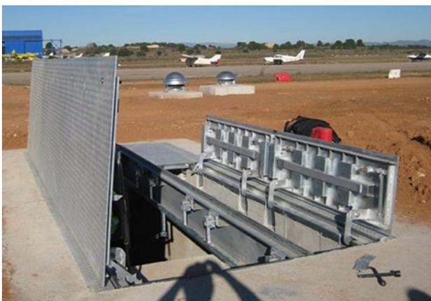
Der Ausgang eines Fluchttunnels bzw. eines Tunnels zur Unterquerung der Rollbahn eines Flughafens. Der Ausgang kann durch Herausnahme der Traverse komplett freigelegt werden.
