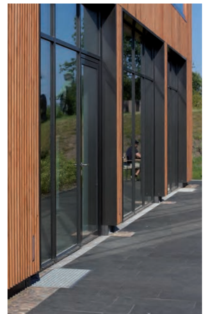
ACO Therm® Block DWD – Austritt Fensterbank, Lichtschacht mit verkürztem Rost
