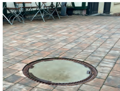
Beispiele für herkömmliche Standardschachtabdeckungen
