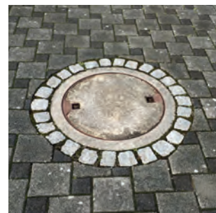
Beispiele für herkömmliche Standardschachtabdeckungen
