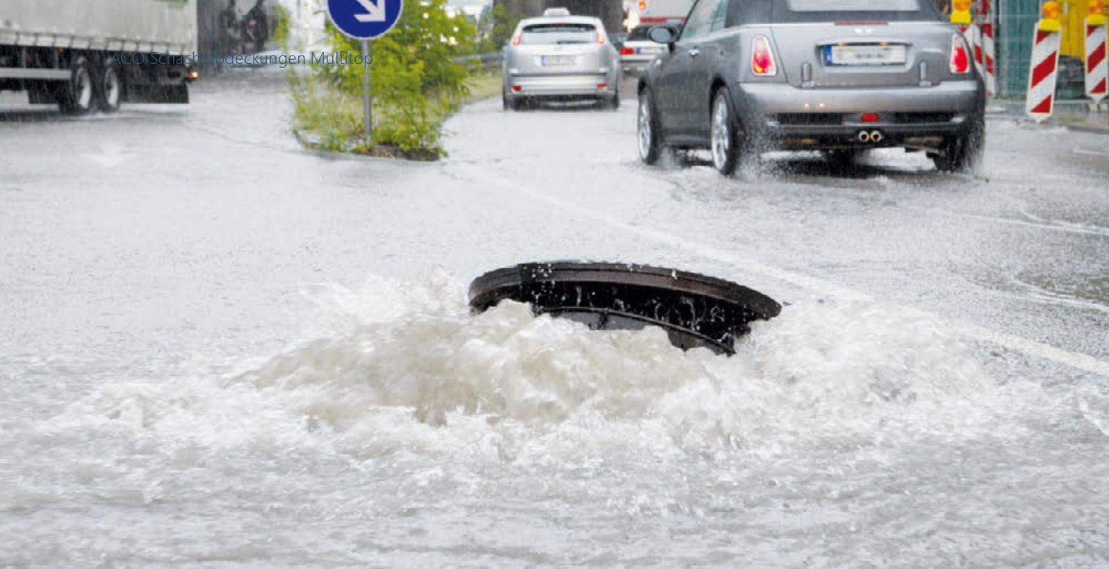
Starkregenereignisse überlasten immer häufiger die Kanalisation. Es entsteht Rückstau. Dabei können Deckel aus dem Rahmen gedrückt und weggeschwemmt werden. Gefährliche offenliegende Schächte sind das Resultat. ACO Multitop Bituplan S minimiert dieses Risiko.
