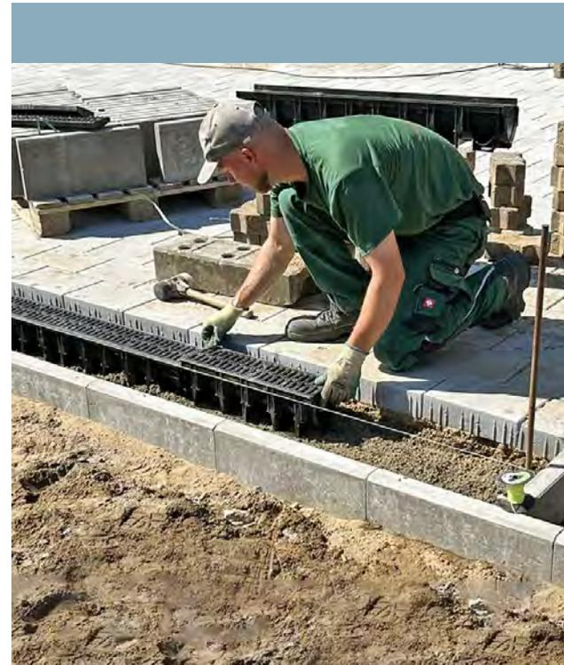
Praktisch ist die Teilbarkeit der 1-Meter-Elemente: Trennt man die ACO XtraDrain an der vorgezeichneten Schnittführung, ist sie auch als 0,5-m-Element einsetzbar.
