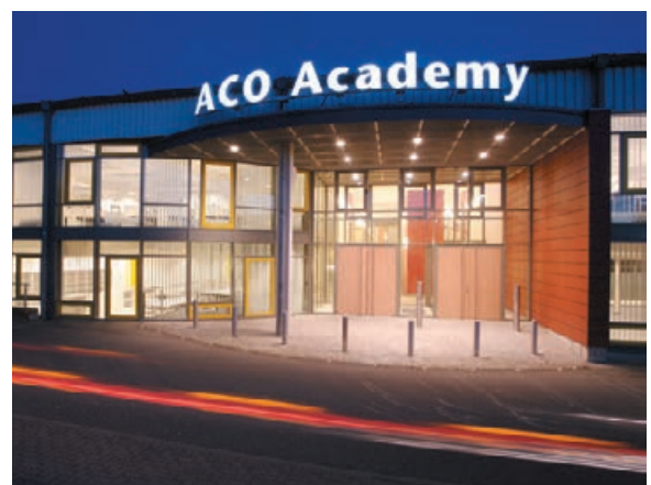
Die ACO Academy in Büdelsdorf/Rendsburg
