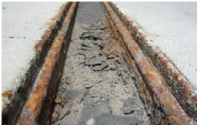
Schadensbild einer korrodierten Rinne durch Tausalz – bei einer Zarge und Rost aus Edelstahl ist dies vermeidbar!
