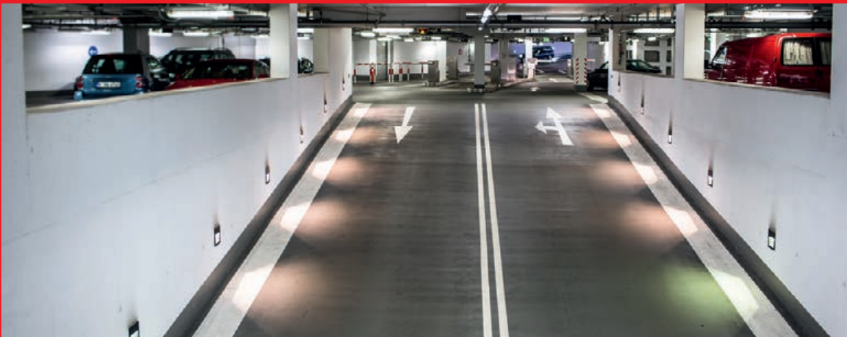
Rampen, Schrägen und Gefälle professionell entwässern
