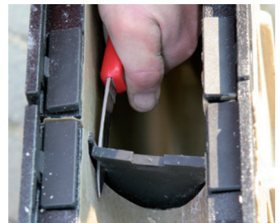
6. Ausschneiden der Anschlusschablone des Einlaufkastens
