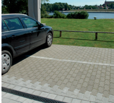
ACO PowerDrain als Parkplätzenwässerung
