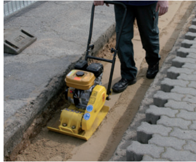
2. Einbringen der Sauberkeitsschicht Verdichten der Sauberkeitsschicht
