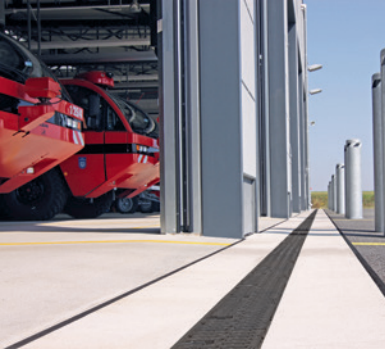
ACO PowerDrain in Zufahrten
