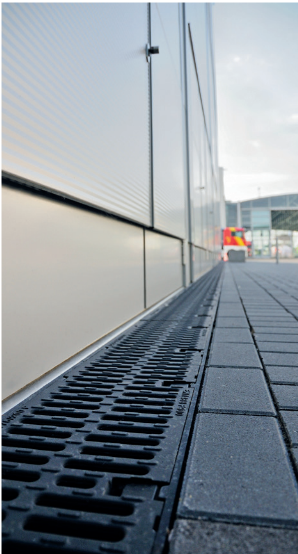
ACO PowerDrain im Außenbereich der Messe Hannover
