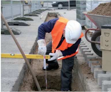
1. Auskoffern für die Verlegung eines V 75/100 P-Rinnenstrangs. Maße entsprechend der benötigten Bauhöhe nehmen
