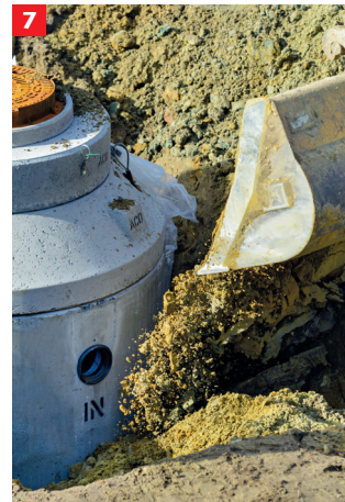
7 Befüllung der Baugrube bis zum Einlauf zum Setzen der Anschlüsse
