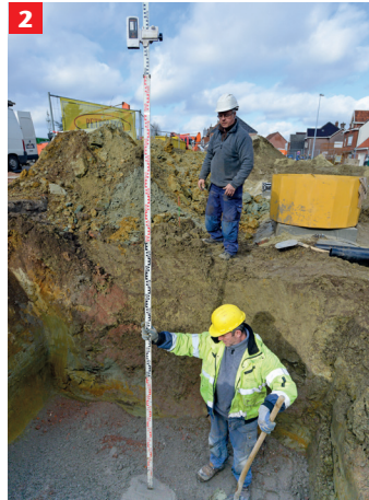
2 Tiefenkontrolle der Baugrube
