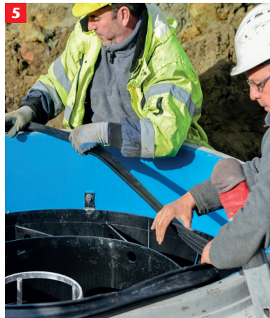
5 Montage der Gleitringdichtung
