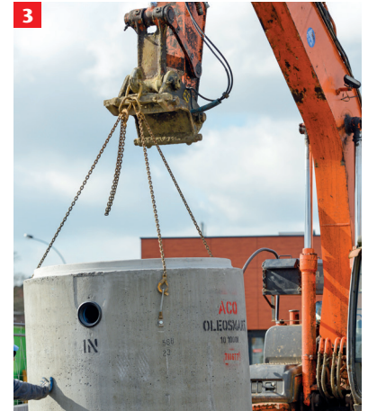
3 Setzen des Stahlbetonbehälters
