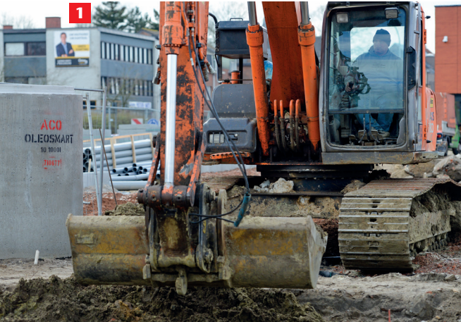
1 Ausheben der Baugrube
