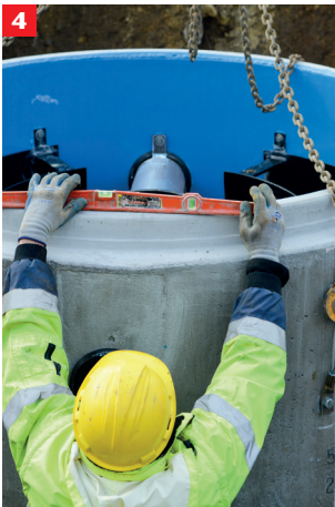
4 Waagerechte Ausrichtung des Behälters
