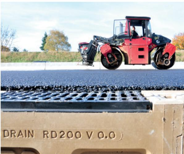
Entwässerung von offenporigem Asphalt
