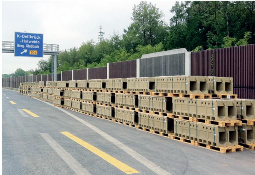
ACO DRAIN® Monoblock RD 300 DF für den Ausbau der A3
