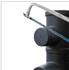
Vor dem Ansetzen des Geruchsverschlusses oberen und unteren Anschlussstutzen am Ablaufschacht öffnen
