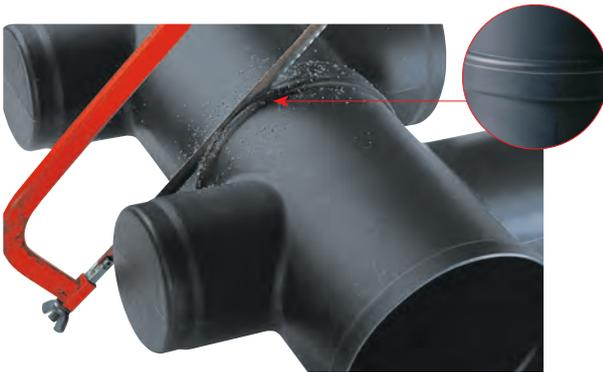
Zum Ablängen des Ablaufschachts zunächst Schmutzfangemier, Ablaufadapter sowie Dichtung entfernen. Anschließend den Ablaufkörper an der gekennzeichneten Schnittlinie trennen. Dichtung und Ablaufadapter auf die Schnittkante des verkürzten Schachts aufsetzen
