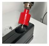
Lochsäge auf Bohrmaschine setzen und Öffnung an der Stelle schneiden, an der der Ablaufstutzen platziert werden soll
