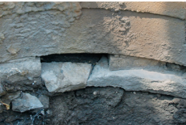
zerstörte Mörtelfuge
