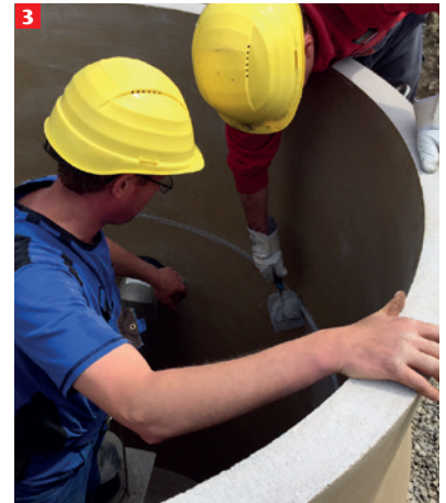
3 Auftragen der Klebefuge und Aufsetzen des Schachtrings
