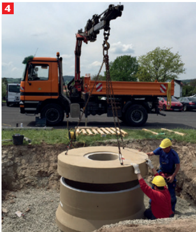
4 Abdeckplatte auf die aufgetragene Klebefuge setzen
