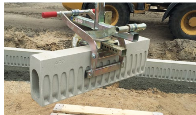
■ Zangen erleichtern das Versetzen der Elemente
