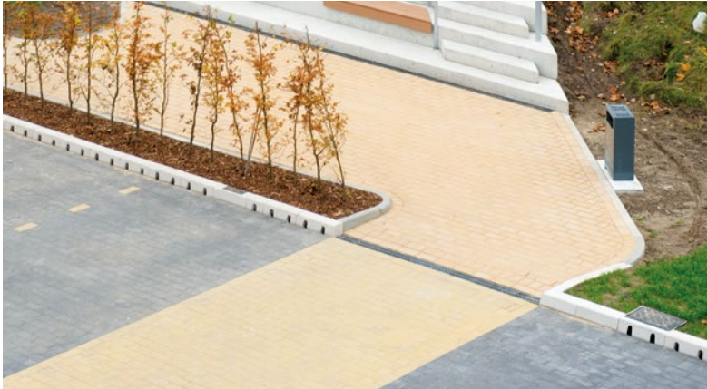
Ein Strang mit Einlaufkasten schützt die Kanalisation vor Verschlammung
