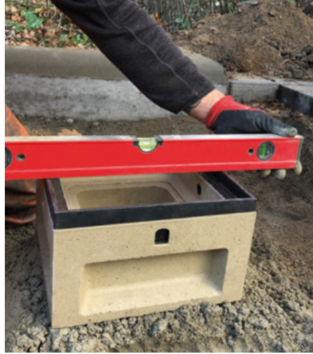
Ausrichten des Ablaufkörpers in der Betonbettung
