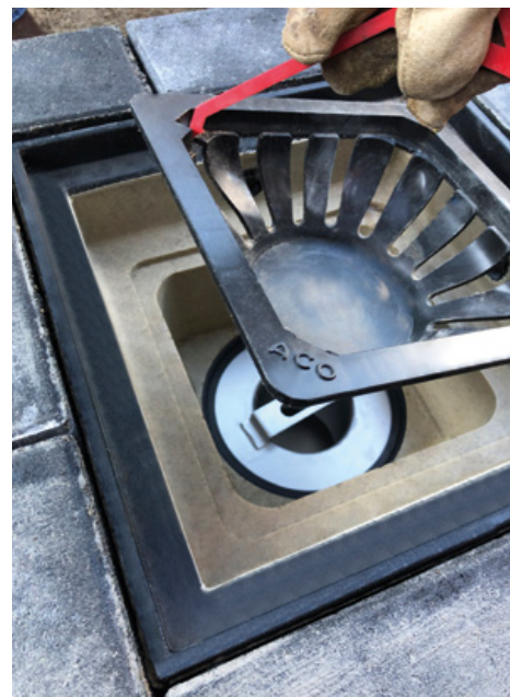
Leichtes Handling des Schlammeimers zum regelmäßigen Säubern
