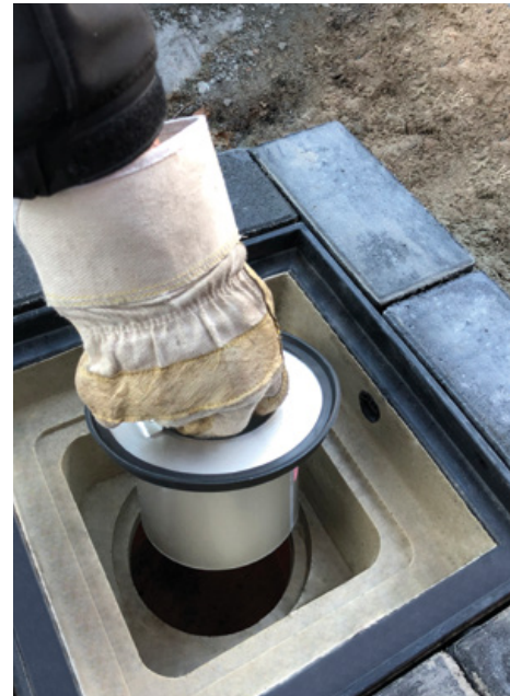
Nachträglich einsetzbarer Geruchsverschluss
