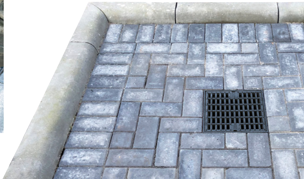
In dieser Ausführung befahrbar bis Klasse D 400
