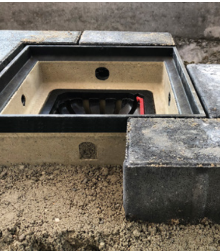
Direktes Anarbeiten des Pflasterbelags
