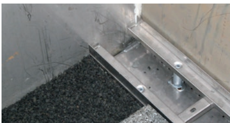
Rinnensystem lose verlegt
