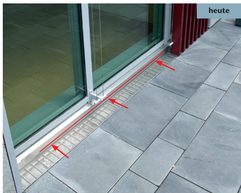
ACO Keilrinne: passgenau vor Fassaden- oder Türanschluss ohne zusätzlichen Kiesstreifen
