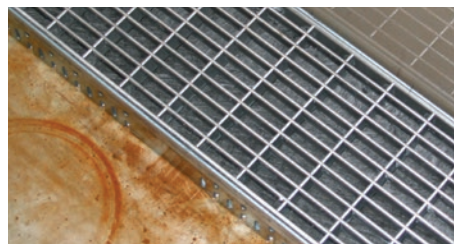
Ein eingelegtes Schmutzvlies reduziert bereits im sauberen Zustand die hydraulische Leistung des Systems um 30%
