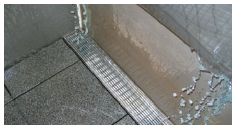
Beregnung der Fassade im Einbau
