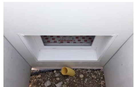
ACO Betonlichtschacht mit Rückwand und Perimeterabdeckrahmen
