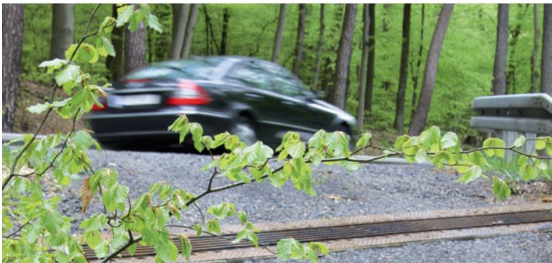
Stopprinne im Nebenweg, starkes Längsgefälle
