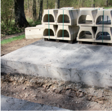
Vorbereiten der Baugrube
