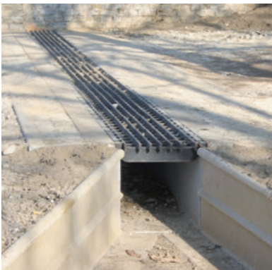
Einbau mit Pflasterkanten
