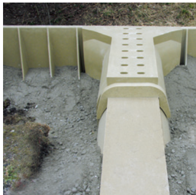
Bau des Eingangsbereichs mit oberflächennahem Tunnel
