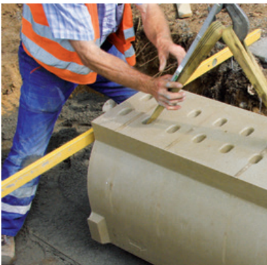
Verlegen der Klimatunnel
