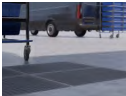
Neu: befahrbarer Rost (Kl. B 125)
