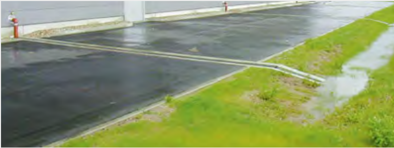
Oberflächennahe Entwässerungsrinnen leiten anfallendes Niederschlagswasser schnell und unkompliziert in die Versickerungsmulden ab
