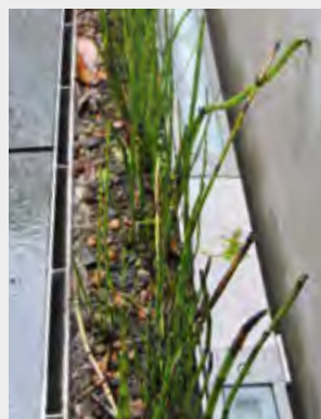
Anfallendes Niederschlagswasser wird gesammelt und oberflächennah zu einer Mulde geleitet
