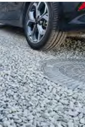
Entsiegeln und Befahren Kiesstabilisierung
