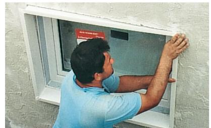
3. Zusammengesetztes Dämmungsanschlussprofil nach Abschluss der Wandbelagsarbeiten in die durch das Entfernen der Schalungsabdichtung freigewordene Nut einsetzen.
