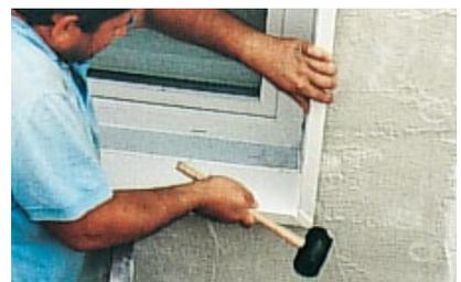
4. Durch Einschlagen in die Nut befestigen (z.B. Gummihammer). Abdichtung zwischen Dämmungsanschlussprofil und Fassade kann mit handelsüblichen Dichtstoffen erfolgen.
