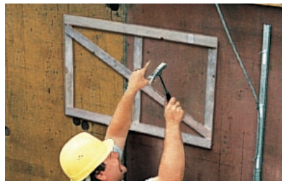
3. Stützkreuz auf der Schalung befestigen.
