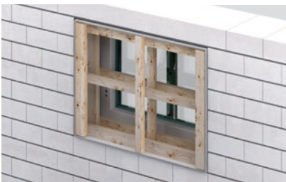
4. Aussteifungen erst nach Erhärten des Mörtels entfernen.
