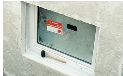
2. Das Dämmungsanschlussprofil ist leicht auf die vor Ort benötigten Dämmstärken bis 140 mm bzw. bis 200 mm mit einem Cutter anpassbar.
