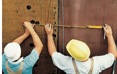
1. Leibungsfenster/Stützkreuz einmessen.
