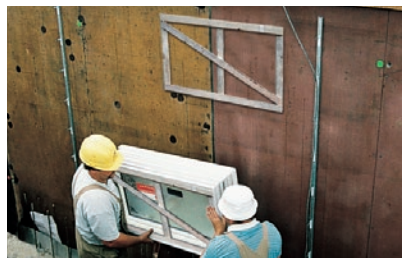
4. ACO Therm® Leibungsfenster auf das befestigte Stützkreuz stülpen und mit den seitlich angebrachten Lochbändern sichern.
