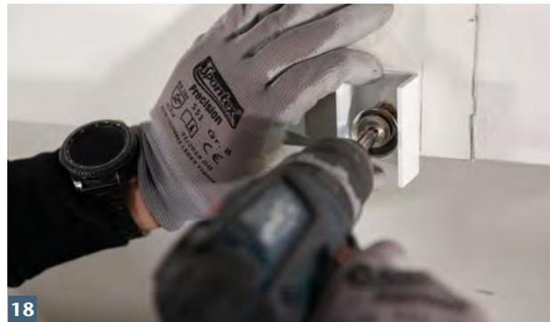
**18** Wandanschlussprofile vom Aufstockelement abnehmen und mit ACO Therm® Block und WDVS verschrauben.
