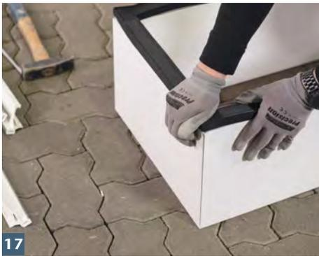
**17** Dichtungsrahmen auf Aufstockelement aufstecken.
