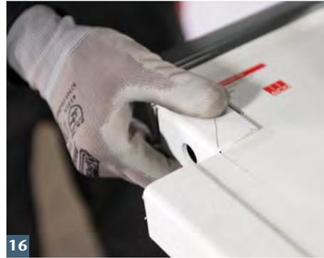
**16** Wandseitige Ausklinkung zur Anpassung an die verspringende Dämmung vornehmen und Wandanschlussprofile aufstecken.
