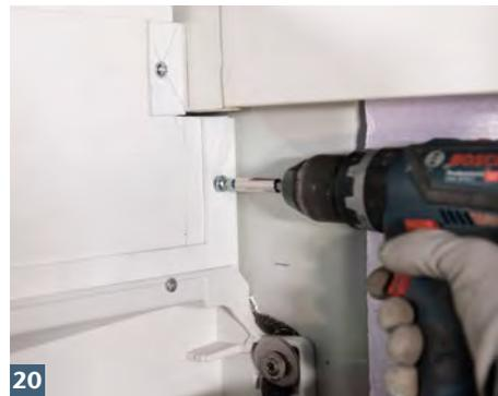
**20** Aufstockelement mit Lichtschacht und Wandanschlussprofilen verschrauben.
