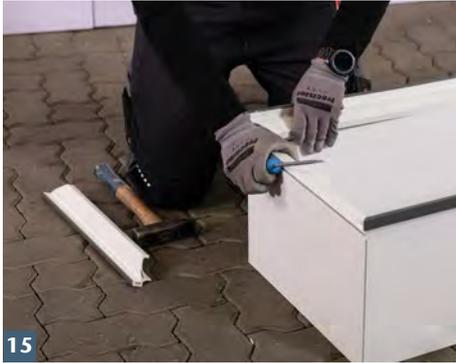
Rostauflageprofil vom Aufstockelement entfernen.
