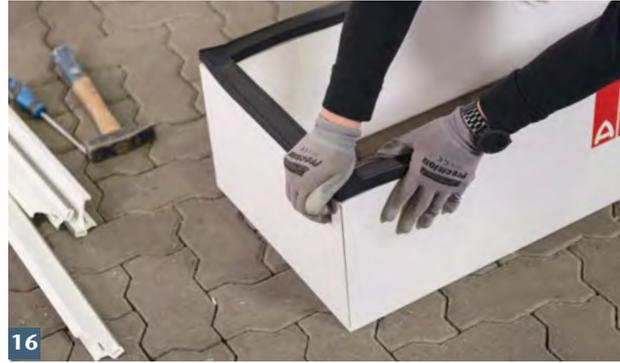
Dichtungsrahmen auf Aufstockelement aufstecken.
