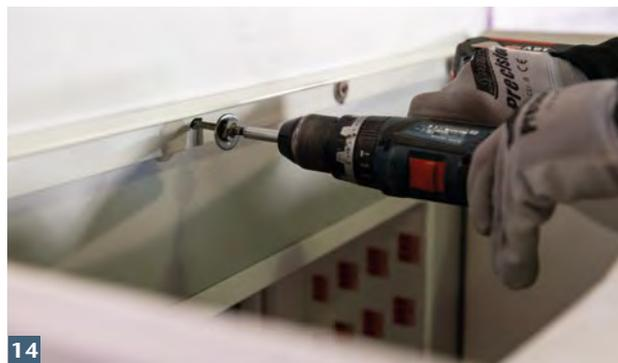
14 Wandanschlusswinkel für wandseitige Auflagerung des Aufstockelements montieren.
