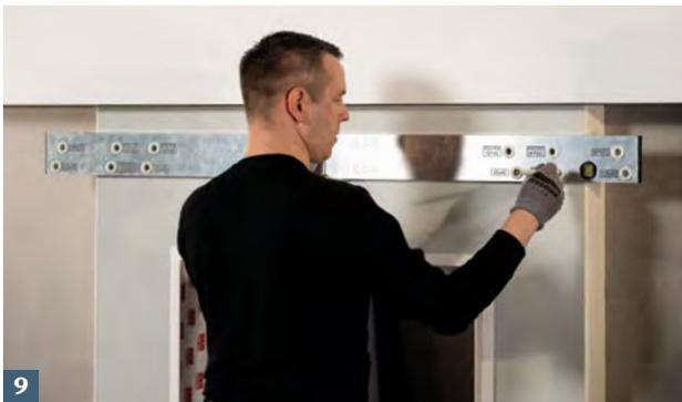
**9** Obere Lichtschachtbefestigungspunkte mit ACO Bohrshablone anzeichnen.
