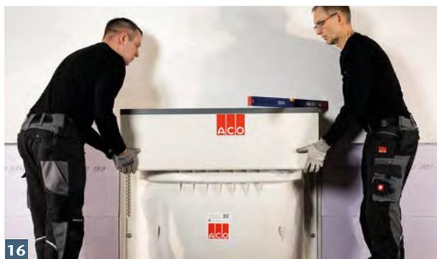
Aufstockelement über Lichtschart schieben und ausrichten.
