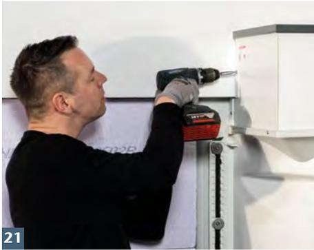
ACO Aufstockelement mit Wandanschlussprofilen verschrauben.
