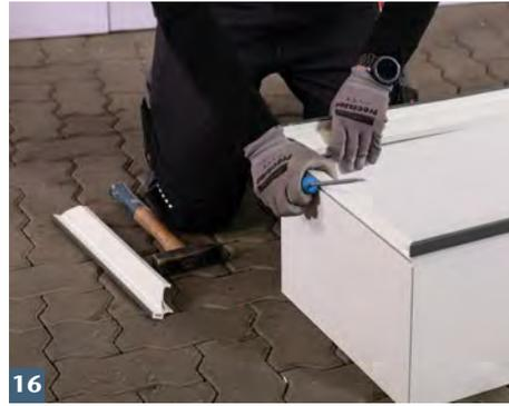
**16** Rostauflageprofil von Aufstockelement entfernen.
