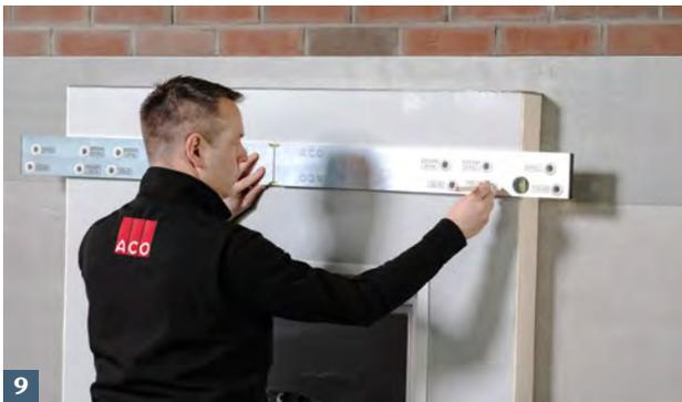
**9** Obere Lichtschachtbefestigungspunkte mit ACO Bohrschablone anzeichnen.
