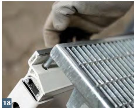
**18** Rostzapfenlöcher ins Aufstockelement bohren und Rost einlegen.
