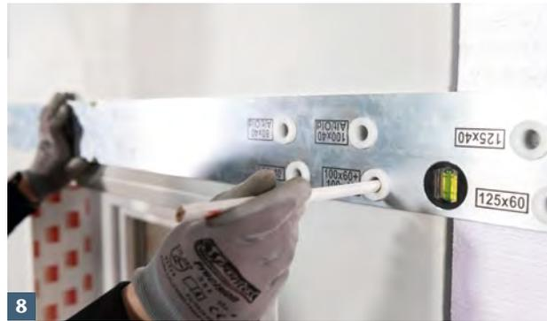
**8** Obere Lichtschachtbefestigungspunkte mit ACO Bohrschablone anzeichnen.
