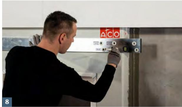
8 Obere Lichtschachtbefestigungspunkte mit ACO Bohrschablone anzeichnen.
