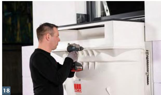
**18** Aufsatzelement mit werkseitiger Aussparung für Lüftungskasten mit dem ACO Therm® Lichtschacht verschrauben.
