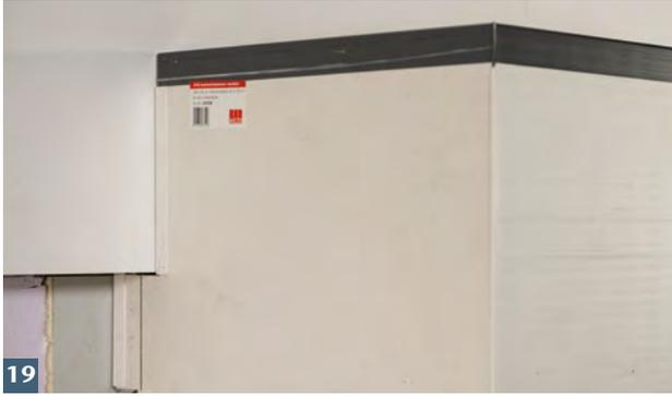
Wandanschlussprofile gegen Dämmung schieben und Rost einlegen.
