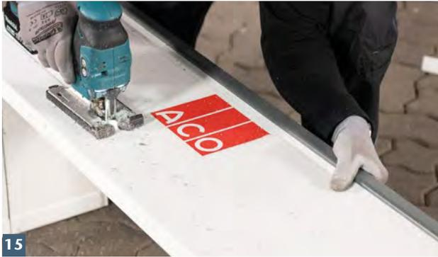
**15** ACO Aufstockelement mit Stichsäge in der Höhe kürzen. U-Profile über Schnittfläche stecken.
