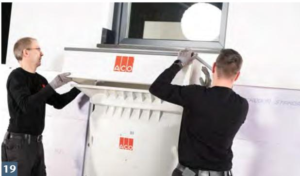
**19** ACO Aufstockelement in Wandanschlussprofile einführen und in Lichtschachtrauflage drücken.
