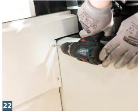
22 Wandanschlussprofile mit Aufstockelement verschrauben.
