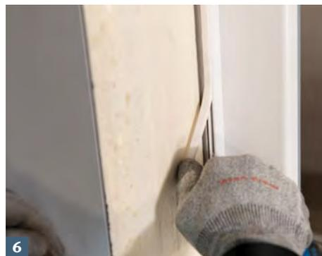
6 Kanthölzern und Montagehilfen entfernen. Schalungsdichtung aus ACO Therm® Leibungskellerfenster entfernen.
