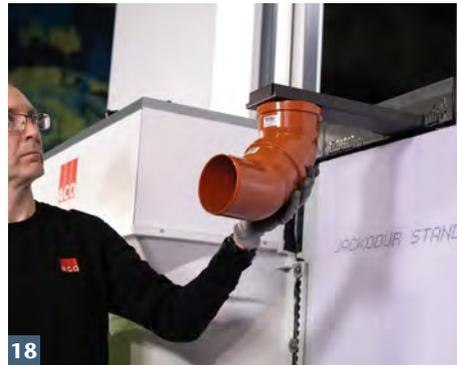
Anschluss der Fassadenrinne mittels eines Leibungsablaufelements an die Entwässerung.
