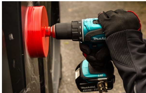
Unten am Tank mit der Lochkreissäge ein Loch für den Anschluss der Retentionsdrossel herstellen
