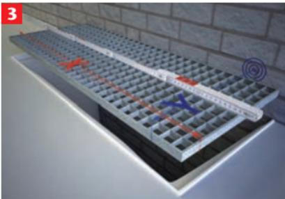
3 Ermitteln Sie die Breite des Gitterrostes (X-Maß). Ermitteln Sie die Tiefe des Gitterrostes und addieren Sie den Abstand zur Wand (Y-Maß). Anschließend können Sie die vier Profilstücke zusägen und den Rahmen zusammenstecken
