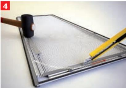
4 Führen Sie das Wandanschlussprofil in die vorgesehene Nut. Stecken Sie die umlaufenden Bürstendichtungen in die vorgesehene Nut. Richten Sie das Gewebe auf der Abdeckung aus. Fixieren Sie das Gewebe mittels des Einschlagkeder. Schneiden Sie das Gewebe rund um den Keder ab
