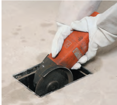
Ausstemmen des alten Kellerablaufs.
