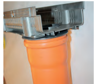
Anschließen des KG-Rohres DN 100
