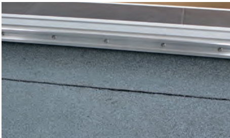
Anschluss einer bituminösen Abdichtung mit Keilausbildung
