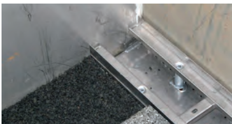
Rinnensystem lose verlegt a
