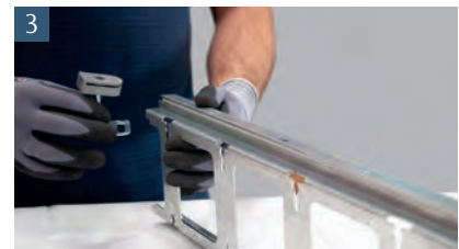
3 Den Kunststoffblock mit dem vormontierten Fuß in die entsprechende Nut bis zum Anschlag einsetzen
