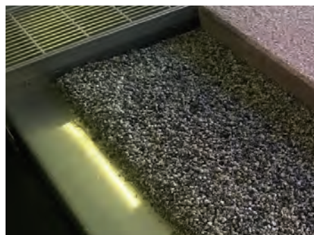
Einbringen von Splitt und anschließendes Verlegen des Plattenbelages
