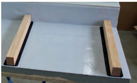
Verlegen der Lagenhölzer auf der Abdichtung. Empfohlener Abstand für den Rinnenkörper sind 50 cm
