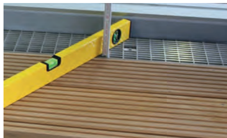
Einpassen der Holzterrassenrinne
