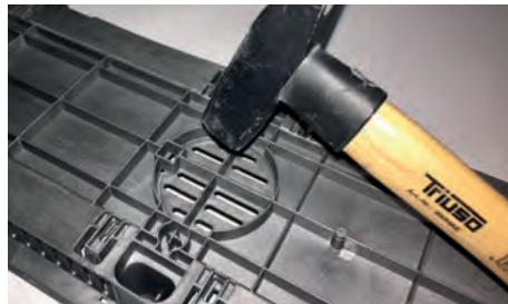
Ausschlagen der Bereichs für den Einsteckstutzen
