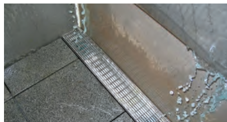
Beregnung der Fassadenrinne im Einbau
