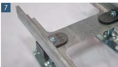
7 Nach dem Einsetzen von min. 4 Füßen kann die Frameline verbaut werden
