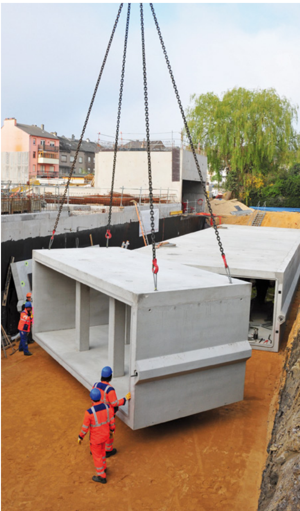
Einbau des Großbehältersystems
