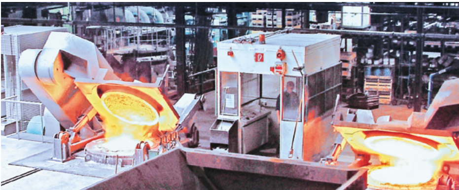
Moderne Mittelfrequenz-Induktions-Schmelzöfen, ACO Kaiserslautern
