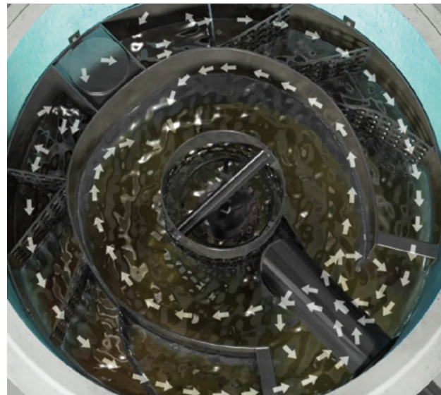
Feinseparation durch lange Fließstrecke
