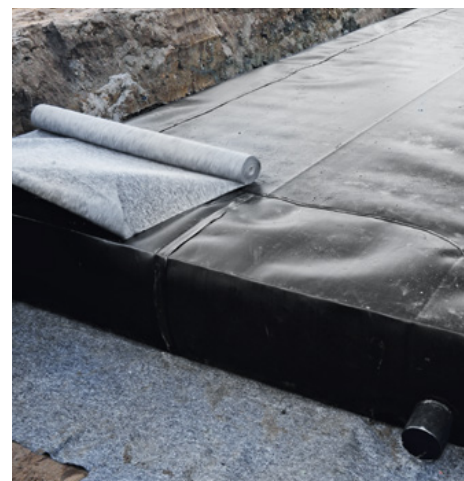
Nach dem Fertigstellen der Abdichtungsbahn wird das äußere Schutzvlies angelegt
