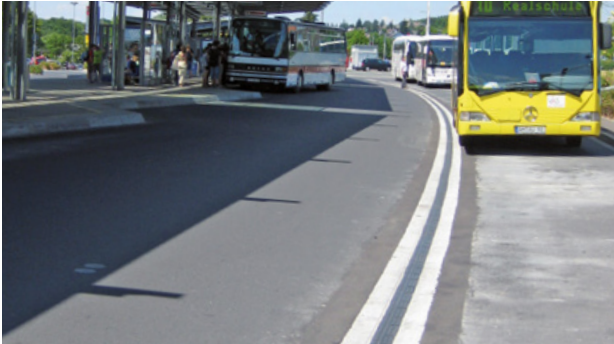
ACO PowerDrain an Busbahnhöfen
