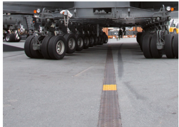
ACO PowerDrain eingebaut in Logistikflächen
