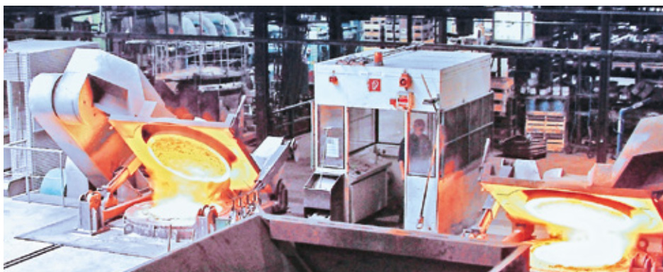
Moderne Mittelfrequenz-Induktions-Schmelzöfen, ACO Kaiserslautern
