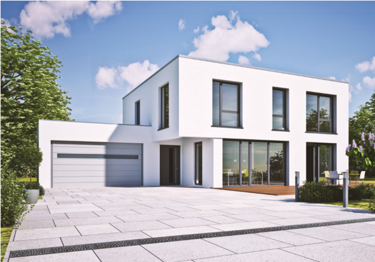
Grundstücks- und Garagenzufahrt mit ACO Self® Entwässerungsrinne
