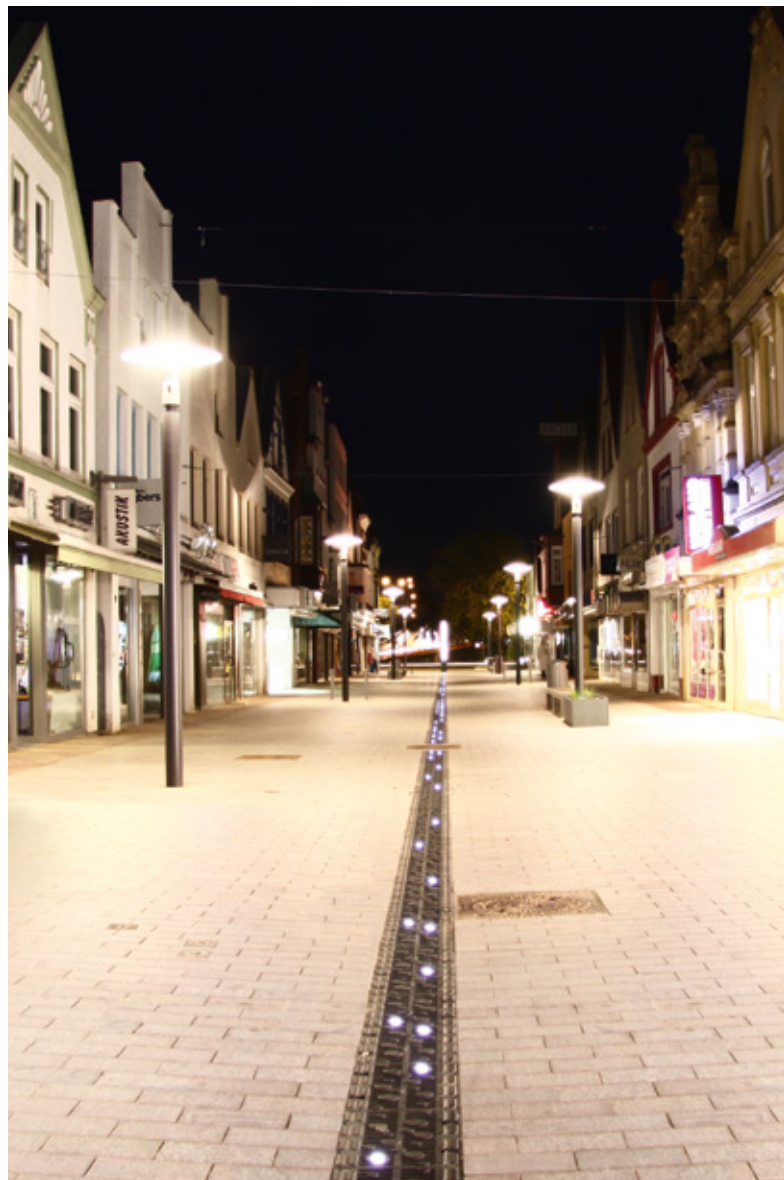
ACO Freestyle Typ „Heiderost“ mit ACO Eyeleds, verbaut in der Friedrichstraße in Heide
