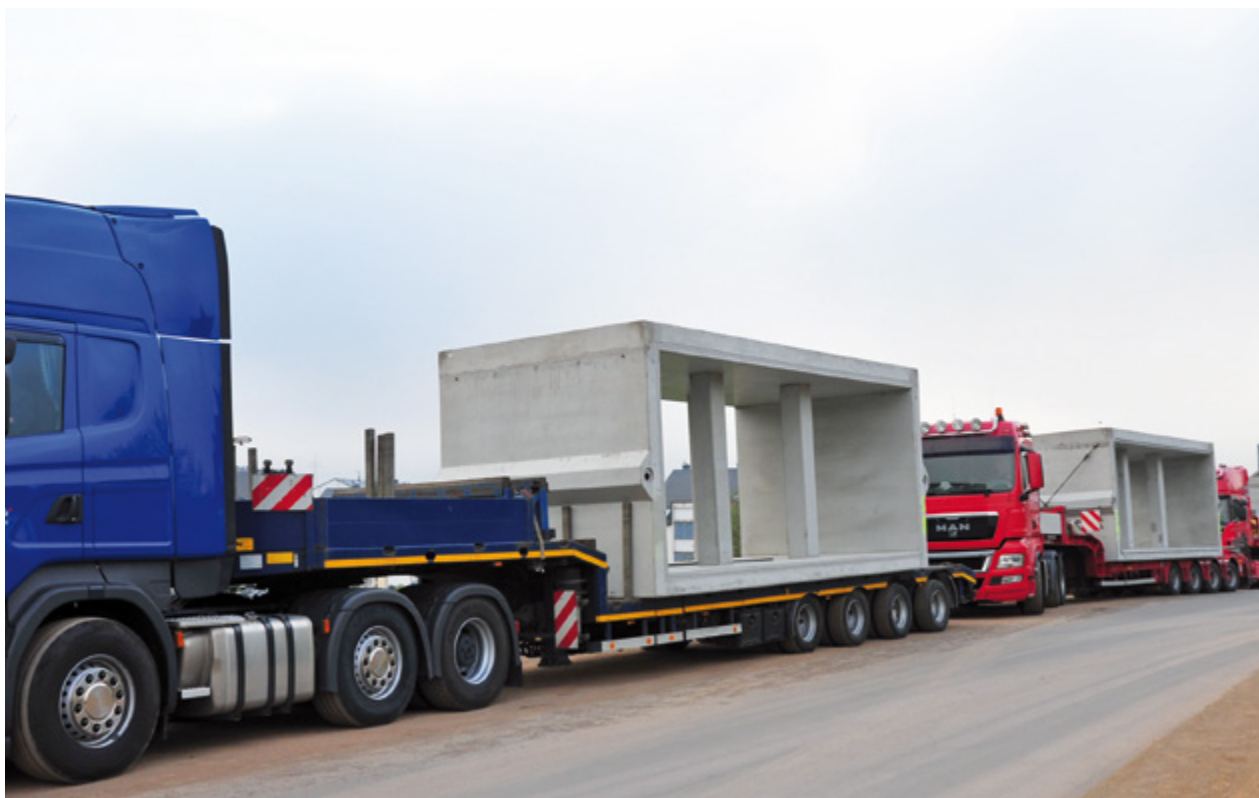
Transport des Großbehältersystems
