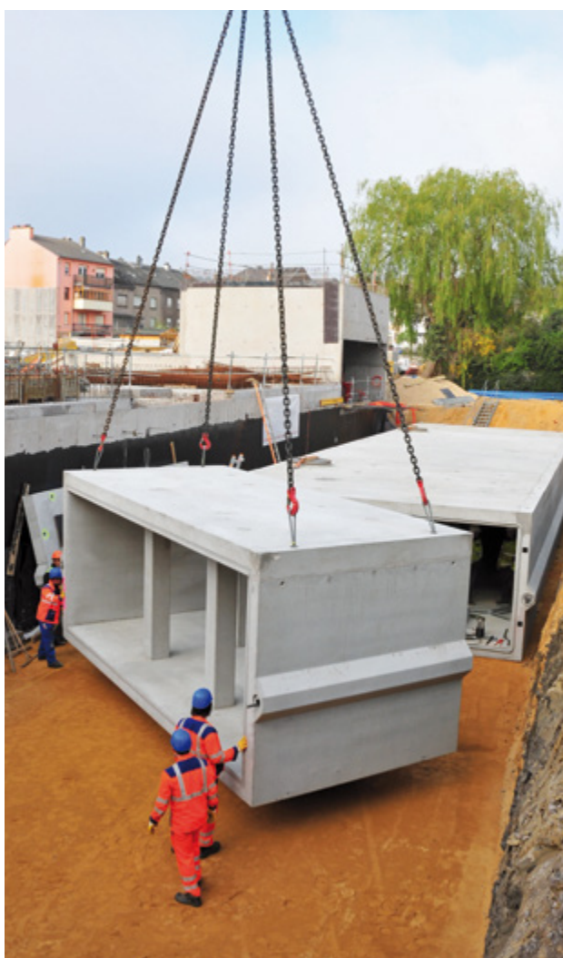
Einbau des Großbehältersystems
