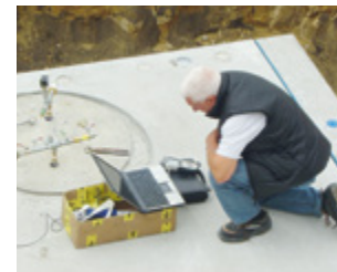
Druckluftprüfung auf Dichtigkeit
