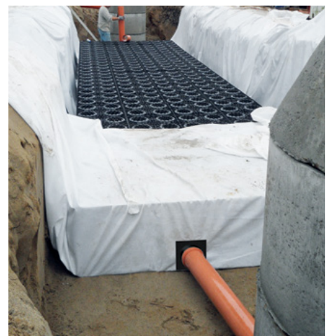
Zulauf von ACO Sedised-C über ein KG-Rohr mit ACO Adapter für Rohranschluss in die Rigole
