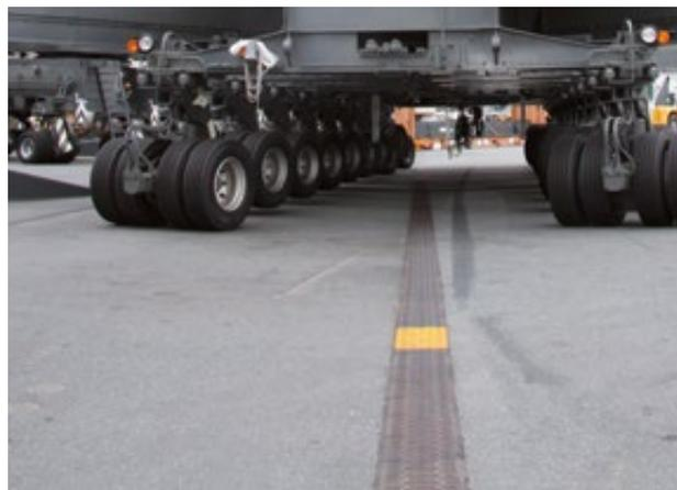
ACO PowerDrain eingebaut in Logistikflächen
