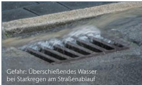
Gefahr: Überschießendes Wasser bei Starkregen am Straßenablauf
