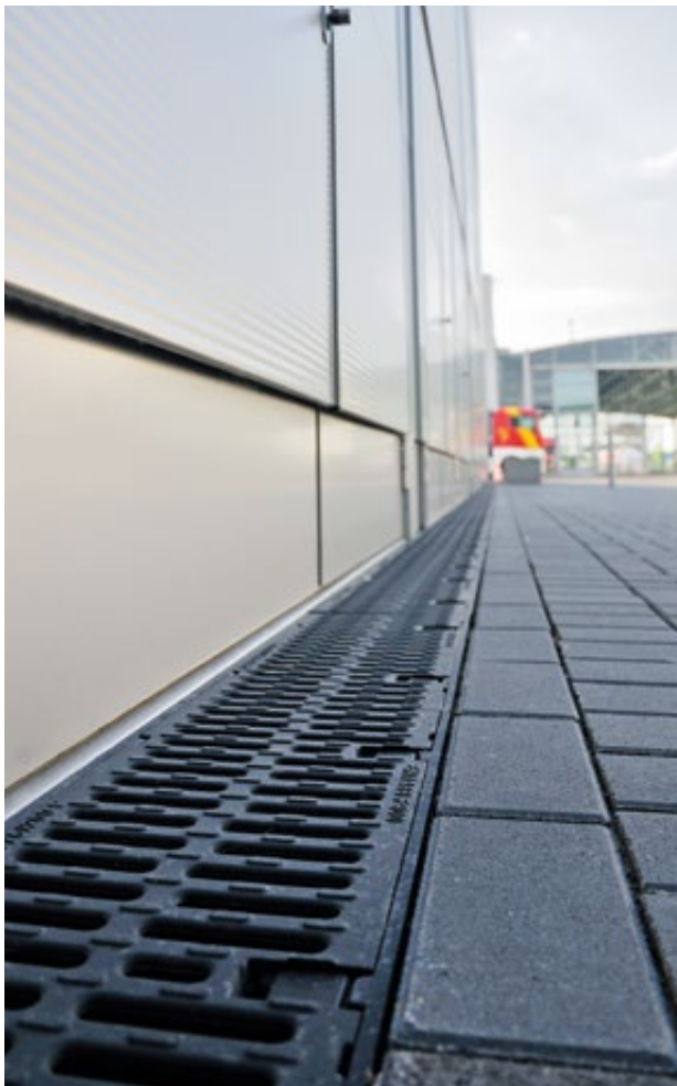
ACO PowerDrain im Außenbereich der Messe Hannover
