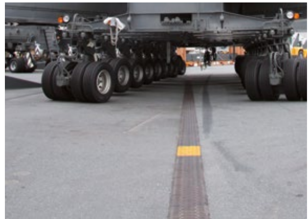
ACO PowerDrain eingebaut in Logistikflächen
