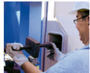
Verbindung mittels Spannstahl
