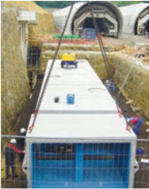
Individuelle Größenauslegung und kurze Installationszeiten mit bewährter hoher Qualität der ACO Betonfertigteile garantieren eine sichere Ausführung und lange Lebensdauer. Für Einbau, Betrieb und Wartung gilt die Richtlinie über den Bau und Betrieb von Straßentunneln. Anlagen nach RABT sind frost- und überflutungssicher einzubauen. Sie müssen rückstaufrei im freien Gefälle betrieben werden. Die gemäß DIN 1986 erforderlichen Leitungsquerschnitte und -werkstoffe sind zu beachten.
