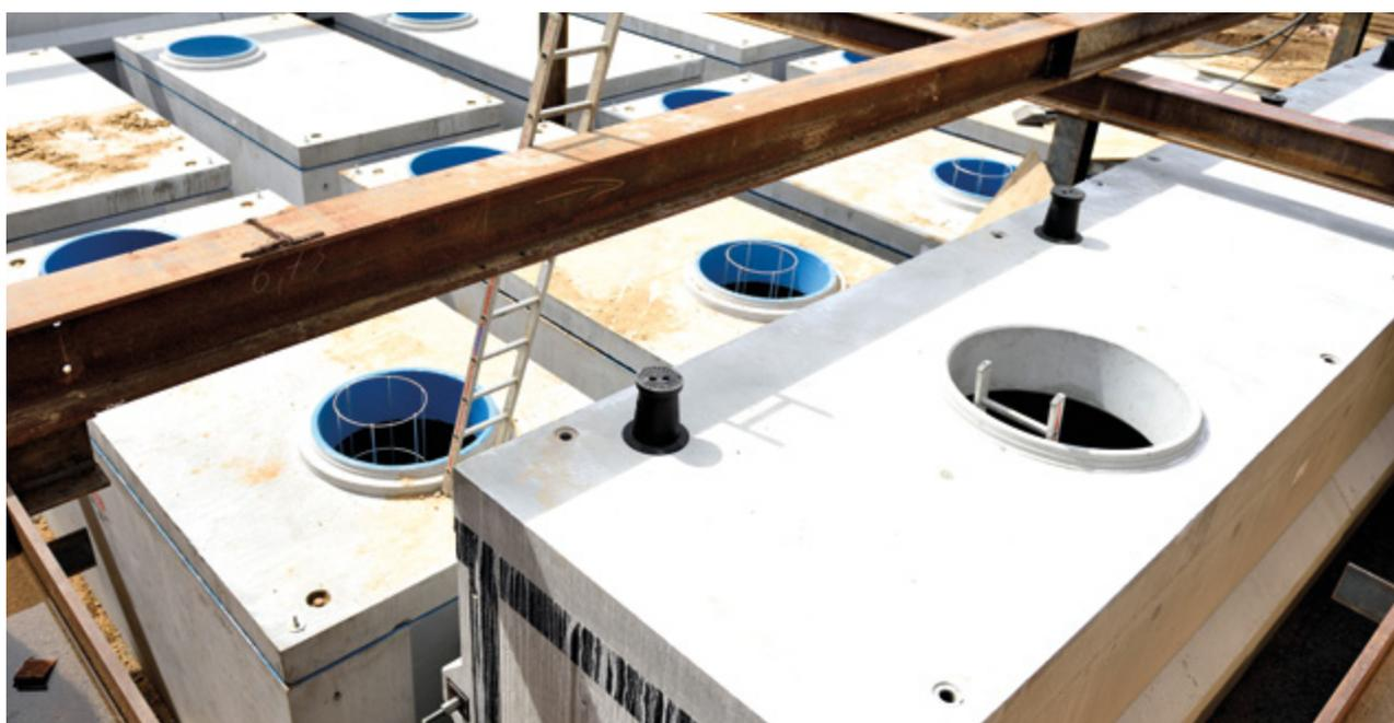
Durch begrenzten Bauraum war bei der Installation der einzelnen Bauteile (Abscheider, Schlammfang, Verteiler- und Sammelkanal) eine absolut präzise Arbeit notwendig.
