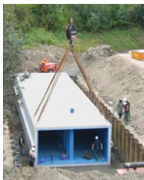
Zu diesen Maßnahmen zählt auch der Einbau von Leichtflüssigkeitsabscheidern. Für Einbau, Betrieb und Wartung von Abscheideranlagen nach RiStWag gilt die Richtlinie für bautechnische Maßnahmen in Wasserrückgewinnungsgebieten, Ausgabe 2002. Abscheideranlagen nach RiStWag sind frost- und überflutungssicher einzubauen. Sie müssen rückstaufrei im freien Gefälle betrieben werden. Die gemäß DIN 1986 erforderlichen Leitungsquerschnitte und Werkstoffe sind zu beachten.
