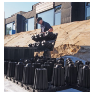
Das System wird aus Grundelementen aufgebaut, die im Verband verlegt werden
