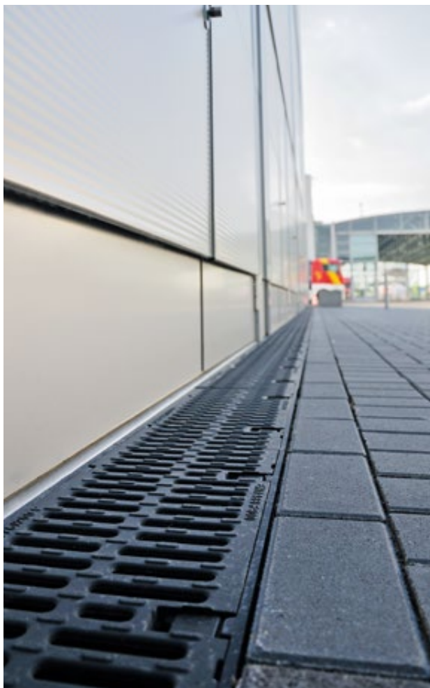
ACO PowerDrain im Außenbereich der Messe Hannover
