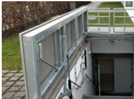
Großformatige, rechteckige Abdeckungen auf Bauwerksöffnungen
