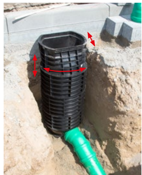
höhenverstellbar, drehbar, neigbar
