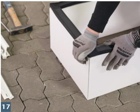
17 Dichtungsrahmen auf Aufstockelement aufstecken.
