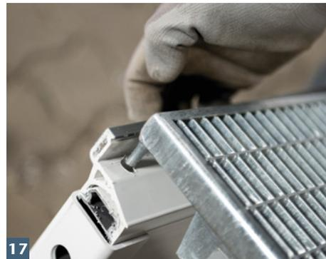
Rostzapfenlöcher ins Aufstockelement bohren und Rost einlegen.
