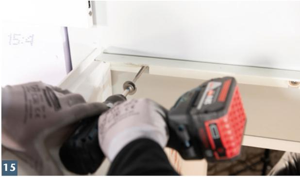
15 Wandanschlusswinkel für wandseitige Auflagerung des Aufstockelements montieren.
