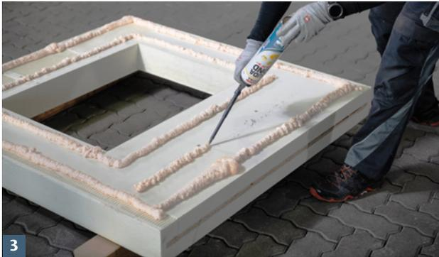
3 Dämmplattenkleber aufsprühen.
