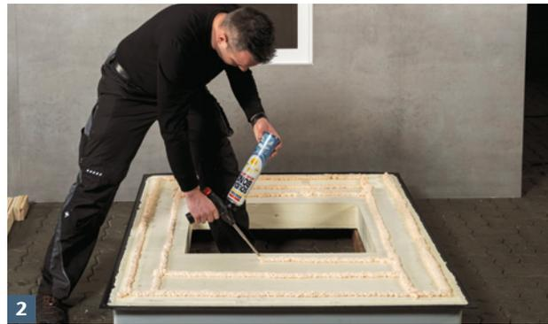
2 Dämmplattenkleber aufsprühen.
