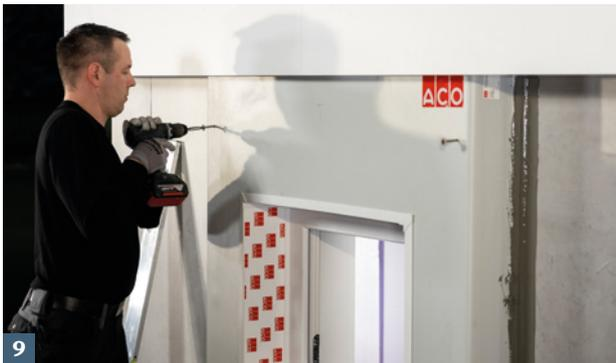
9 Die oberen beiden Schrauben für die Lichtschachtbefestigung eindrehen.
