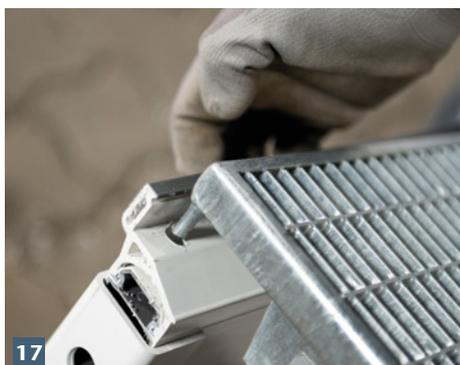
17 Rostzapfenlöcher ins Aufstockelement bohren und Rost einlegen.
