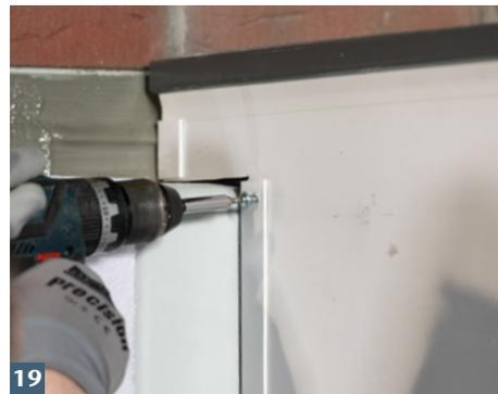
ACO Aufstockelement mit Lichtschacht und Wandanschlussprofilen verschrauben.
