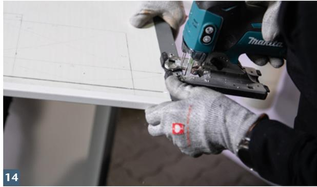
14 ACO Aufstockelement und Wandanschlussprofile mit Stichsäge an rückspringende Klinkerfassade anpassen.
