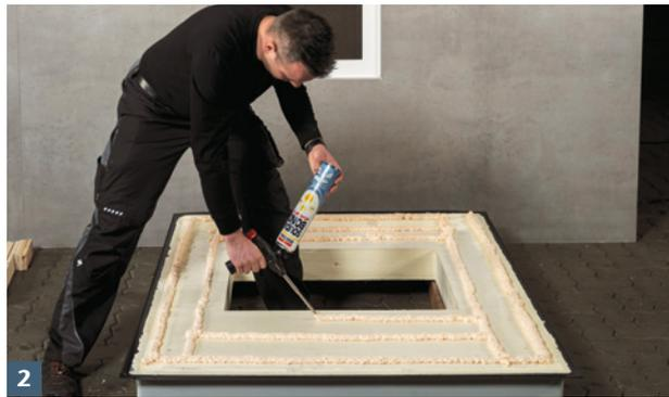
2 Dämmplattenkleber aufsprühen.
