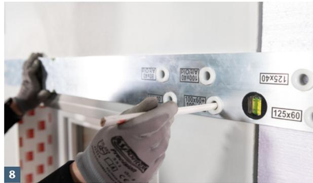
8 Obere Lichtschachtbefestigungspunkte mit ACO Bohrschablone anzeichnen.
