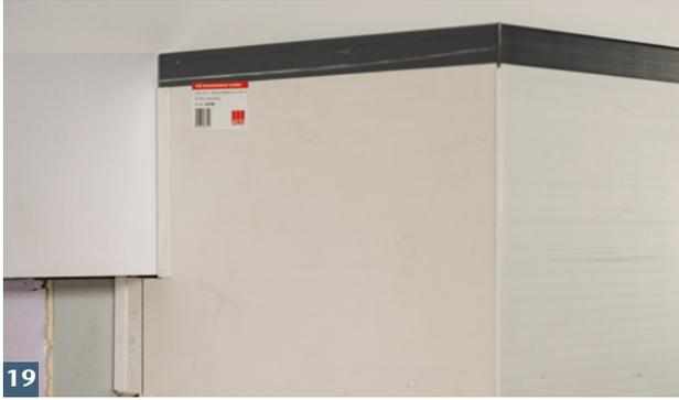
Wandanschlussprofile gegen Dämmung schieben und Rost einlegen.
