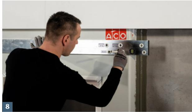
8 Obere Lichtschachtbefestigungspunkte mit ACO Bohrschablone anzeichnen.
