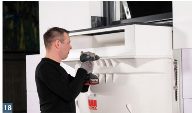
18 Aufsatzelement mit werkseitiger Aussparung für Lüftungskasten mit dem ACO Therm® Lichtsacht verschrauben.
