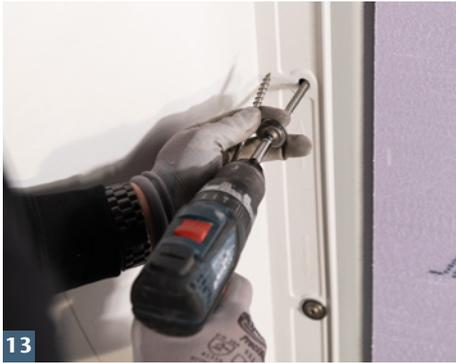
Schrauben rundum mit Kontakt zum ACO Dichtfixband eindrehen.
