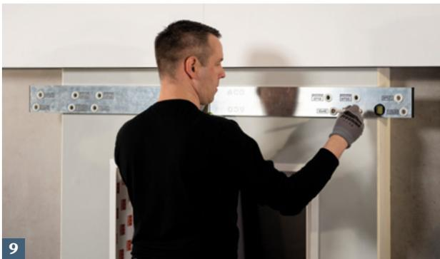
**9** Obere Lichtschachtbefestigungspunkte mit ACO Bohrschablone anzeichnen.
