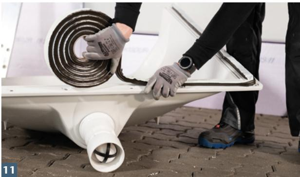
11 Selbstklebendes ACO Dichtfixband auf sauberen Lichtschachtflansch aufkleben.
