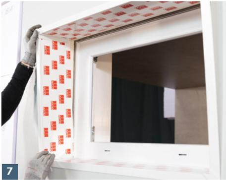
7 ACO Dämmanschlusprofil in Nut des ACO Therm® Leibungskellerfensters einklicken.
