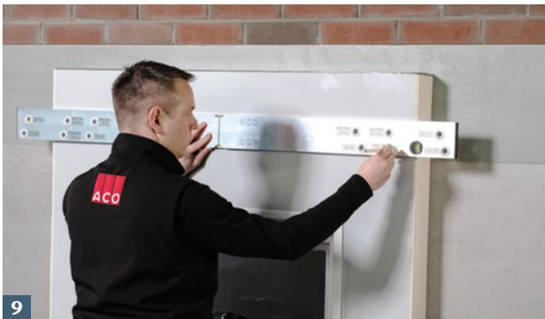
**9** Obere Lichtschachtbefestigungspunkte mit ACO Bohrschablone anzeichnen.
