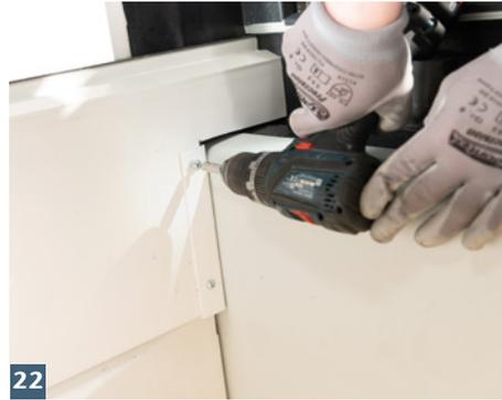
22 Wandanschlussprofile mit Aufstockelement verschrauben.
