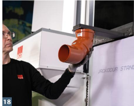
Anschluss der Fassadenrinne mittels eines Leibungsablaufelements an die Entwässerung.
