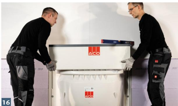
Aufstockelement über Lichtschart schieben und ausrichten.
